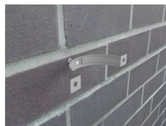
Montaż obejm do ściany odbywa się za pomocą kołka rozporowego i śruby.
